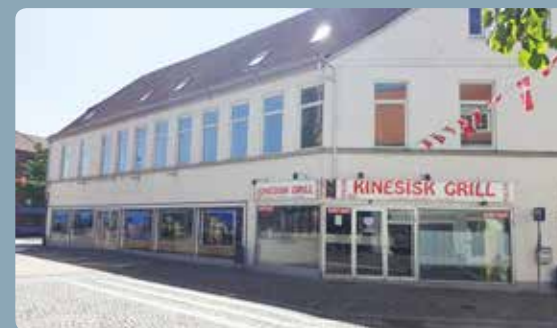
Der ydes byfornyelsesstøtte med 50% til nedrivning af boligdelen af ejendomme.
