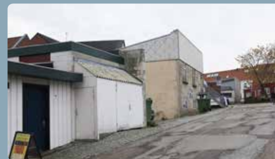
Der ydes støtte til klimaskærme, nedrivning, etablering af badefaciliteter samt afhjælpning af nedslidt udtryk.
